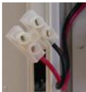
Рисунок 9. Кабель для подключения замка к блоку питания
